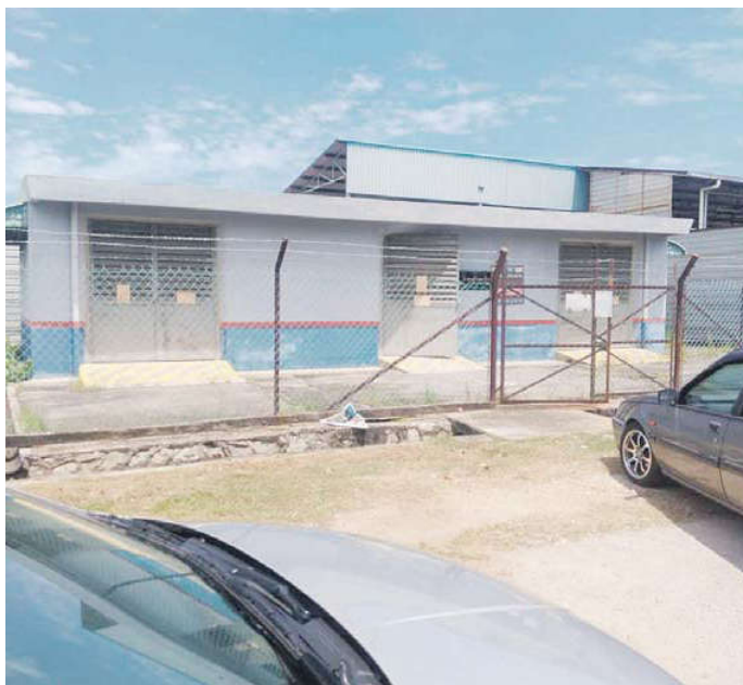
Lokasi suspek melecur akibat terkena renjatan ketika curi kabel elektrik.
