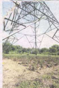
SETIAP tanaman yang ditanam di bawah rintisan talian TNB tidak boleh berketinggian lebih daripada 1.52 meter.
